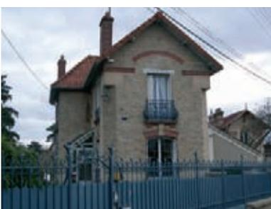
La tuile mécanique rouge, le zinc, la pierre calcaire ou meulière, l'enduit chaux et ciment, le bois sont les matériaux traditionnels des "villégiatures".
