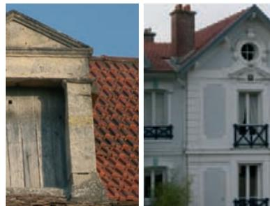
Les tuiles, les ardoises se patinent sous l'action du soleil et des intempéries. La couleur des toitures de tuile plate, plusieurs fois remaniées, s'enrichit de nuances variées.
