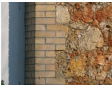
Brique silico-calcaire et pierre meulière entourée de cailloux composent les murs des "villégiatures" de Coye. Le bois peint est utilisé comme parement, débord de toit, garde-corps, balcon, menuiserie, ...
