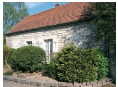
On observe des corniches en plâtre sur les façades ainsi que des encadrements, des bandeaux, des harpes en enduit lissé.
