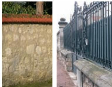
Les murs sont montés avec de la pierre de taille, de la meulière, du moellon calcaire et grès.
