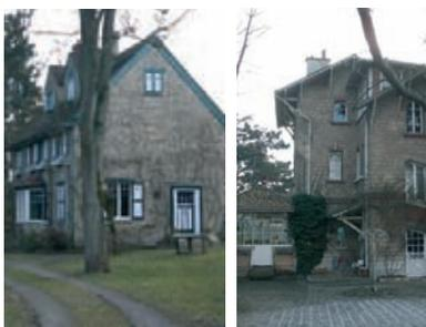
La tuile plate, l'ardoise, le zinc, les faux pans de bois en enduit teinté (recham-pissage), le bois, la brique argile ou silico-calcaire, la pierre de taille, le moellon équerri ou bosselé, l'enduit lissé ou tyrolien sont les matériaux des maisons forestières.
