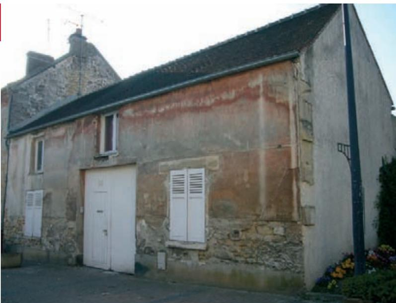
La façade était toujours protégée par un enduit recouvrant les moellons. Ce revêtement teinté est habillé par des bandeaux et encadrements clairs lissés.
