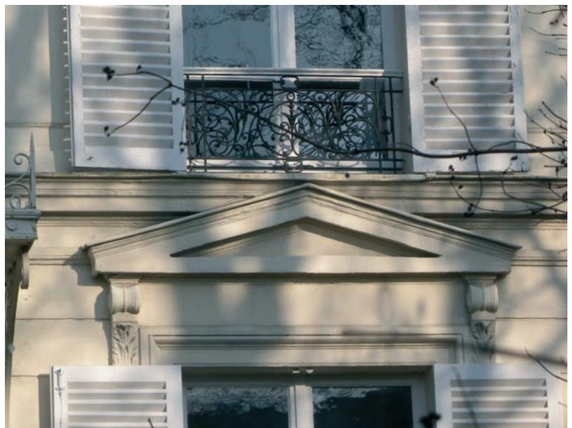
Les ouvertures dans les murs, facteurs de fragilité, font l'objet de nombreux détails soignés. Les façades sur rue des constructions du XIX<sup>ème</sup> sont traitées par de riches ornements de plâtre ou pierre comme les frontons, les modillons, les pilastres, les entablements... Le plâtre de ces éléments est protégé par des bavettes de zinc. Des ferronneries habillent les baies.
