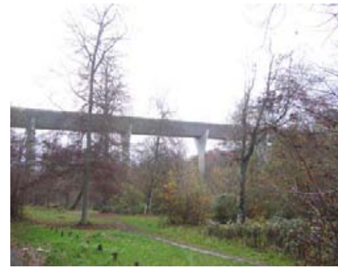
3. Le viaduc SNCF
