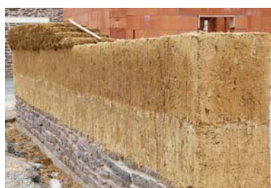
Mur en bauge en cours de construction
