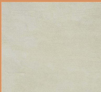
Enduit couvrant étiré à la taloche
