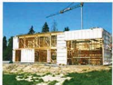
Chantier d'une maison à ossature bois
