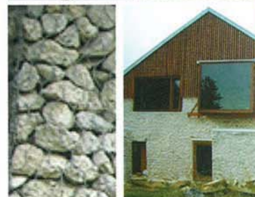
Matériaux : résilles métalliques pour plantes grimpantes, mur en gabion (caisson en treillage métall rempli de caillasse), pignon en moellon enduit à pierre vue et clins de bois associés aux fenêtres cadrées
